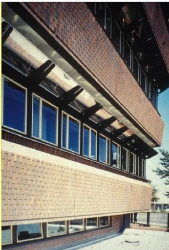
**Fig. 51** Utilización en la fachada del *light shelf* en oficinas.
