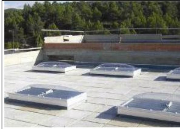
**Fig. 90** Detalle de la cubierta del lucernario
