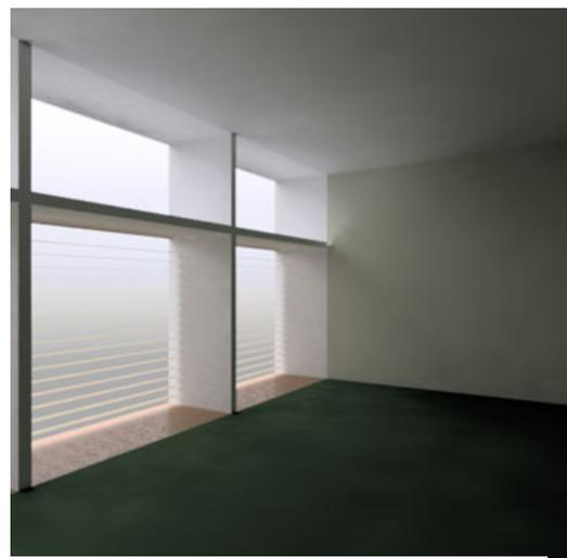
**Fig. 48** *Light shelf* con cielo nublado con película especular de alta reflectancia
