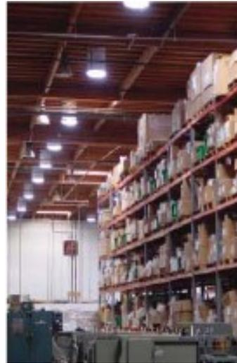
**Fig.75** Iluminación con ductos lumínicos en una bodega
