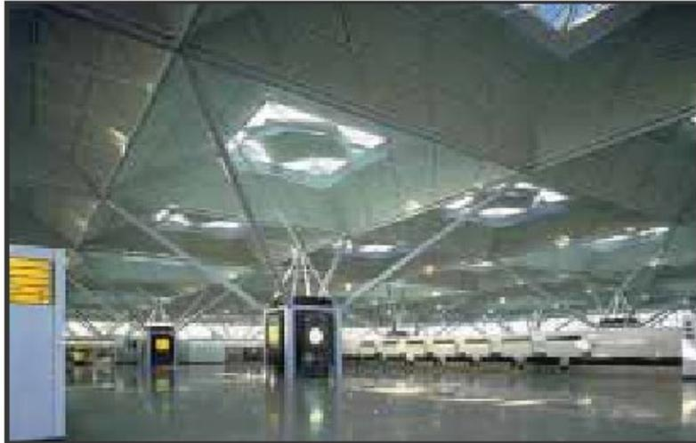
**Fig. 64** Sistemas de iluminación cenital. Aeropuerto de Stansted, Londres. Norman Foster 1990.
