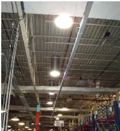
**Fig. 42** Espaciamiento de ducto lumínico.
