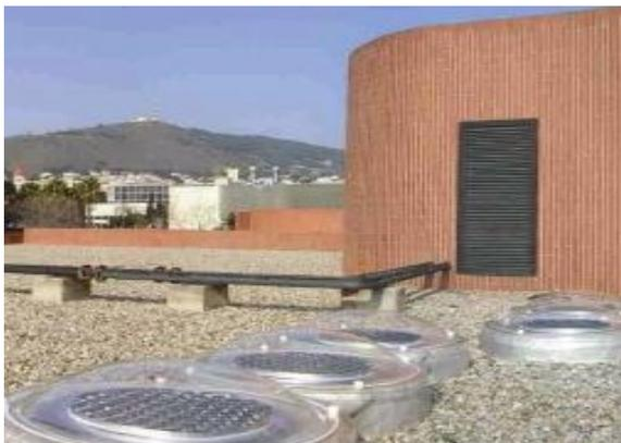
**Fig. 80** Espaciamiento de ductos en el techo
