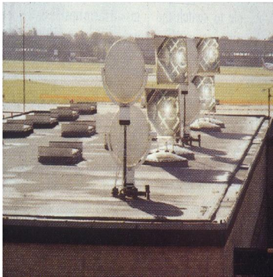
**Fig. 59** Utilización de lentes cóncavos y convexos en la azotea del edificio London.
